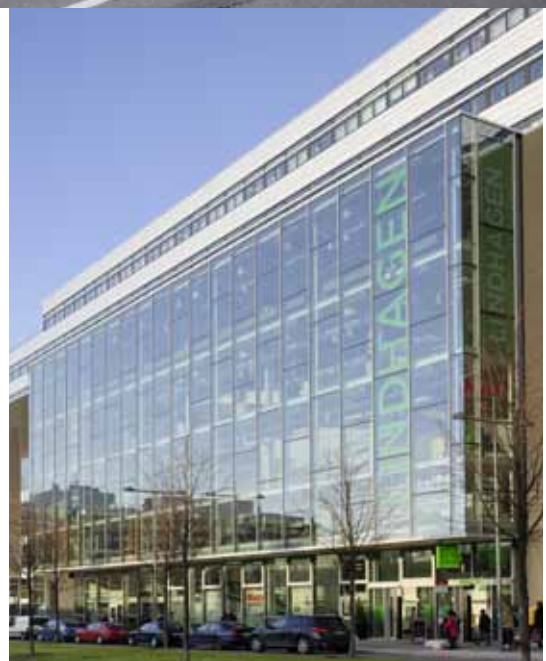
Semi- structural glazing fasad, Stockholm Med integrerade fönster- och dörrenheter
