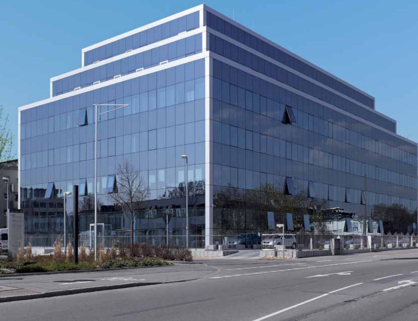
Semi- structural glazing fasad, Stockholm Med integrerade fönster- och dörrenheter
