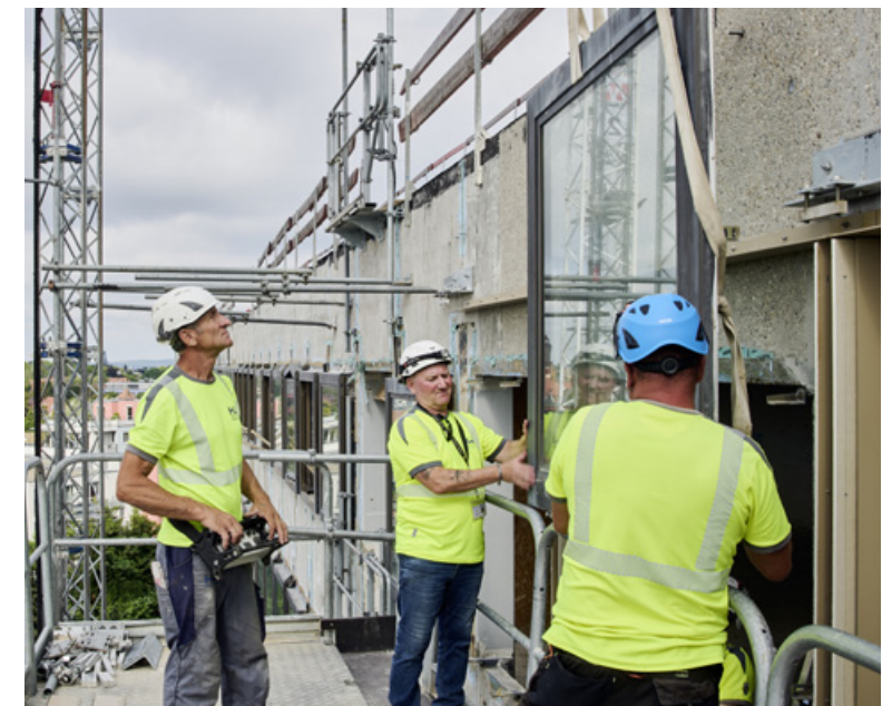
Die 50 Jahre alte Bandfenster-Fassade aus Aluminium und Glas wurde komplett rückgebaut.
