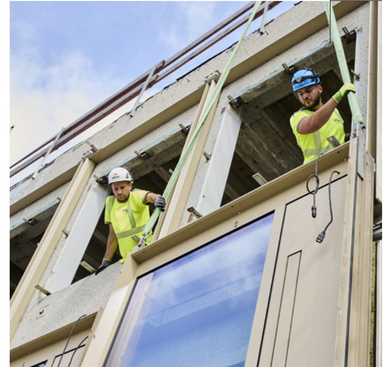
Abschließend wurde die neue Elementfassade auf Basis der Wicona Wictec EL – hergestellt aus Hydro Circal 75R – am Gebäude montiert.
