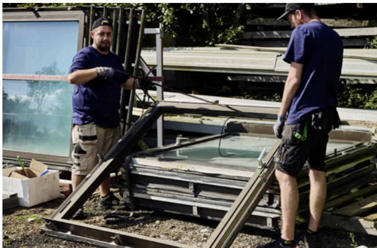
Auf dem Werksgelände von Heinrich Würfel wurden die alten Fenster entglast und die Materialien dann sortenrein getrennt.
